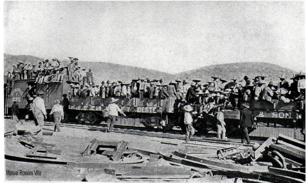
Descargando Acero, para Transportar humanos
